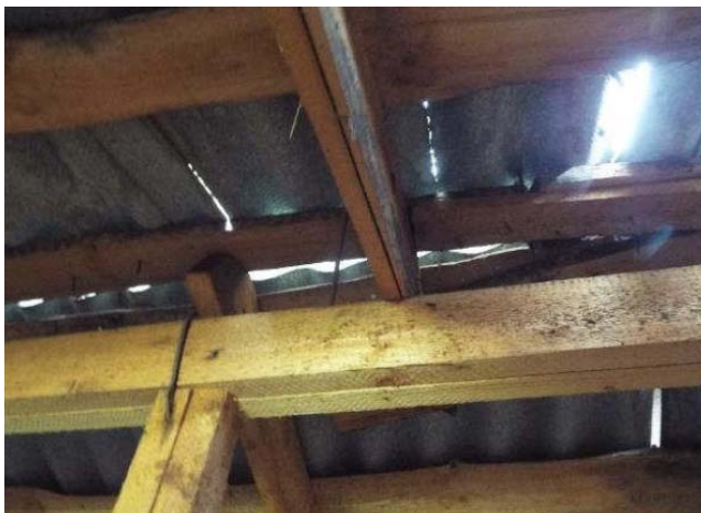
Рис. 3. Повреждение асбестоцементных волнистых листов, отсутствие пароизоляционной пленки, отсутствие огнебиозащитного покрытия элементов стропильной системы
