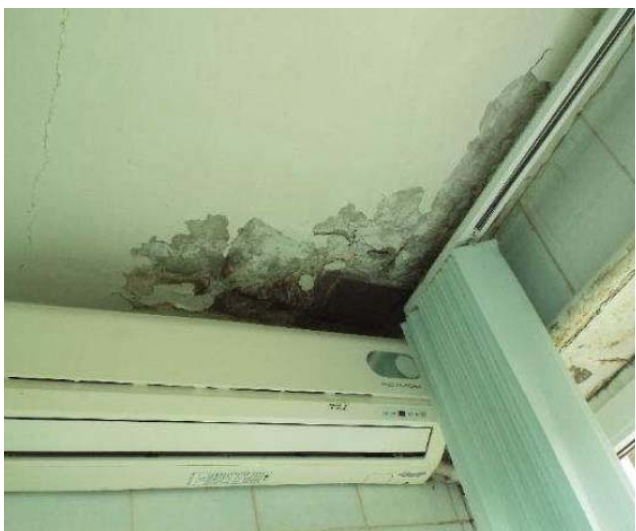
Рис. 4. Замачивание плиты покрытия и утеплителя кровли здания
