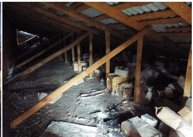
Рис. 3. Повреждение асбестоцементных волнистых листов, отсутствие пароизоляционной пленки, отсутствие огнебиозащитного покрытия элементов стропильной системы
