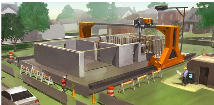
Рис. 1. Изготовление ограждающих конструкций при помощи 3D-принтера «СтройБот»
