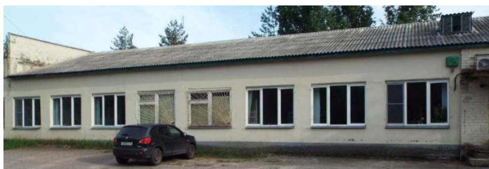
Рис. 1. Общий вид здания лаборатории
