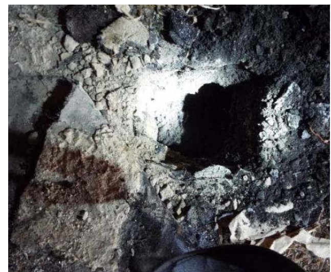
Рис. 4. Замачивание плиты покрытия и утеплителя кровли здания
