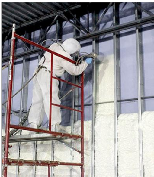
Рис. 6. Нанесение жидкой теплоизоляции 2
